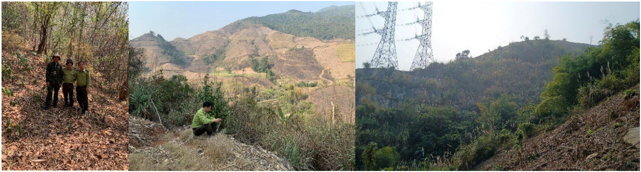
Tư vấn lập hồ sơ chuyển đổi mục đích sử dụng rừng Dự án Đầu tư xây dựng Đường tỉnh 120C (Yên Châu - Tạ Khoa)
